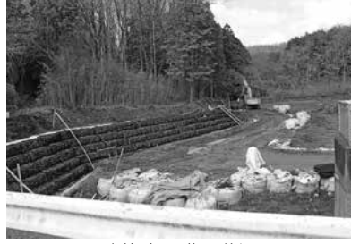
改修中の北ヶ谷沼
