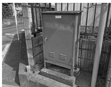
隣の消火栓格納箱
