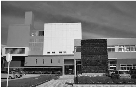
4月から本稼働した「埼玉西部クリーンセンター」
