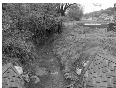
上流に向かい右岸だけが改修工事の対象に含まれる辻川
