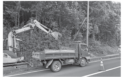
町道第2号線災害復旧工事（施工中）
