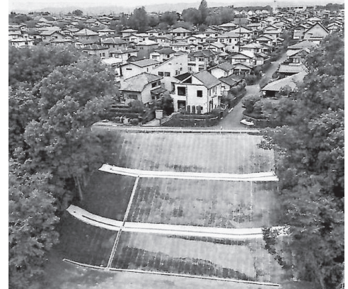
楓ヶ丘3丁目の緑地法面（工事完了）
