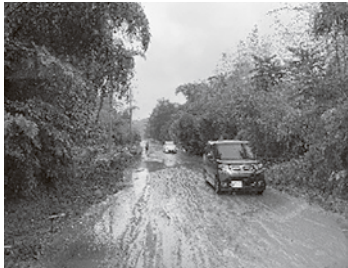
大雨で冠水した県道
