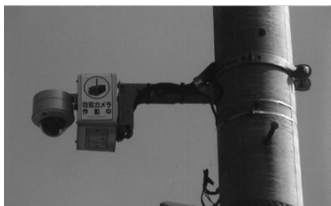
県が設置した監視カメラ
