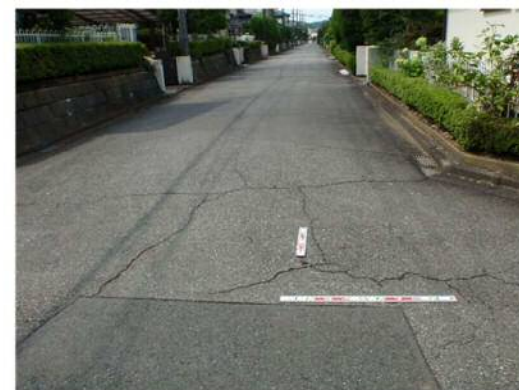
写真②: 路面に無数のクラック (5mm 程度)
