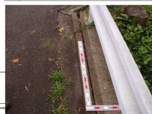
写真⑥: 末端部擁壁背後の開き (10~20mm 程度)
