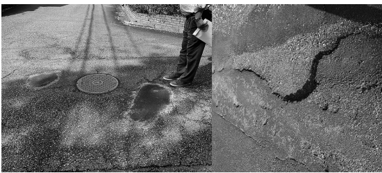
段差の激しい町道と下水管付近の穴あき（応急修繕時）
