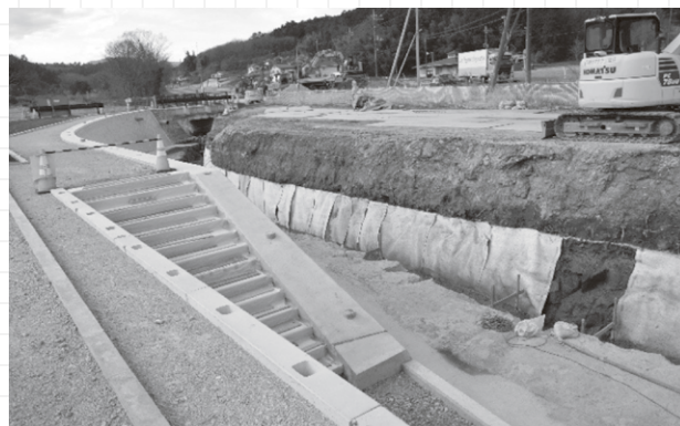
辻川周辺の工事の様子
