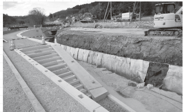
辻川周辺の工事の様子
