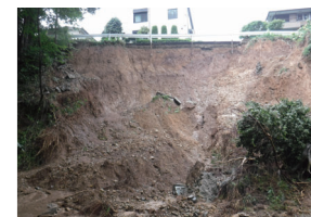
▲楓ヶ丘地区の路肩・法面崩落、側溝・ガードレール損壊・電柱・カーブミラー損壊
