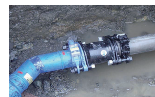
▲水道管布設工事（青色の管が最新のもの）
