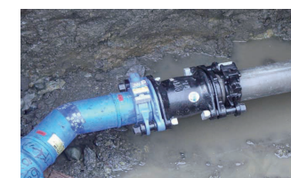
▲水道管布設工事（青色の管が最新のもの）
