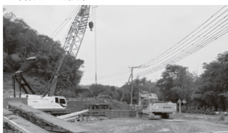
架け替え工事が始まる重郎橋
